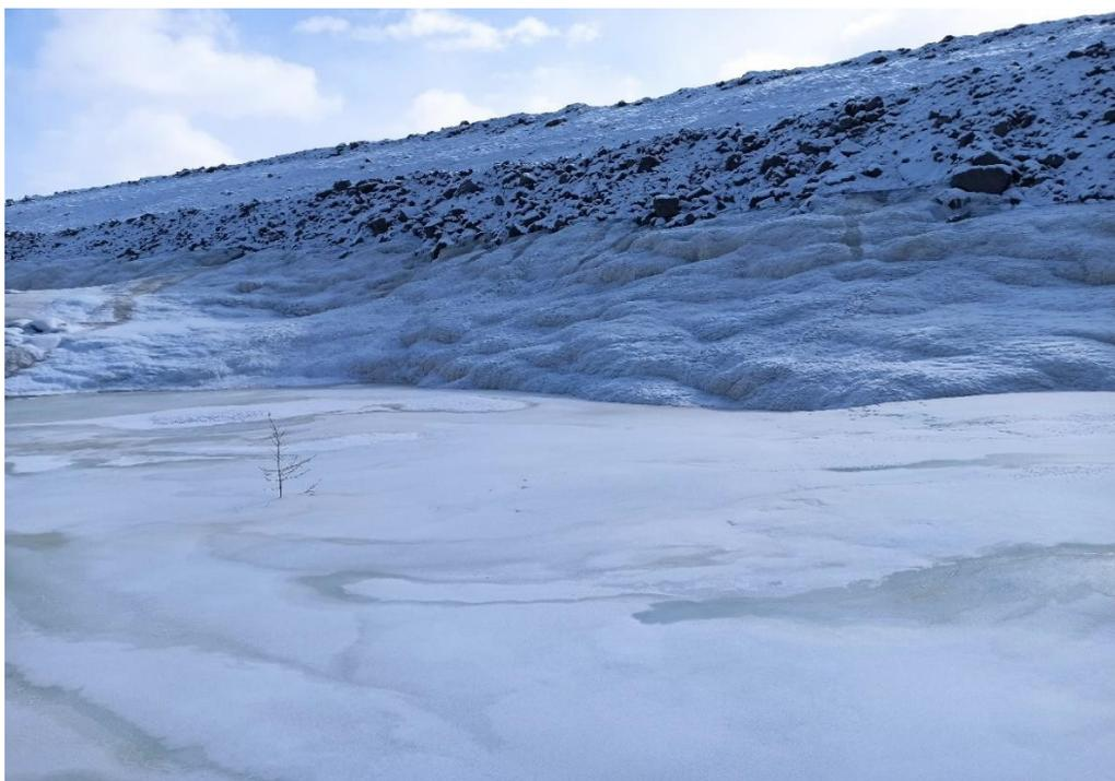
Рисунок 5 – Фильтрация вод в теле дамбы с образованием наледей
