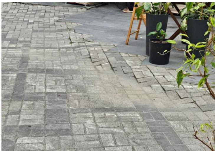
Рисунок 2 – Деформации тротуарного покрытия
