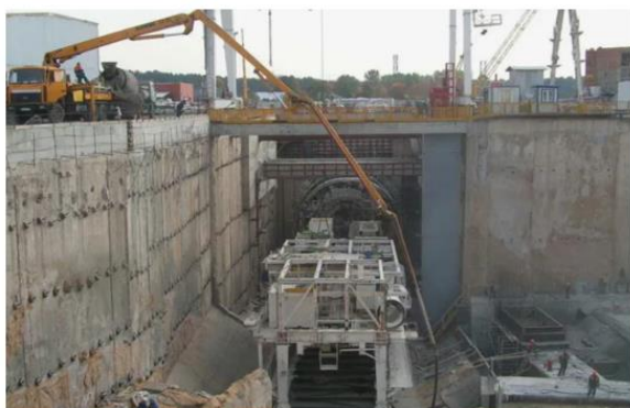
Метод "стена в грунте"
