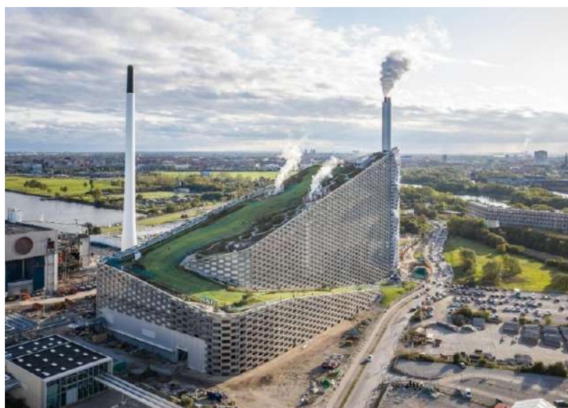
Рисунок 3 – Центр утилизации отходов. Копенгаген, Дания
