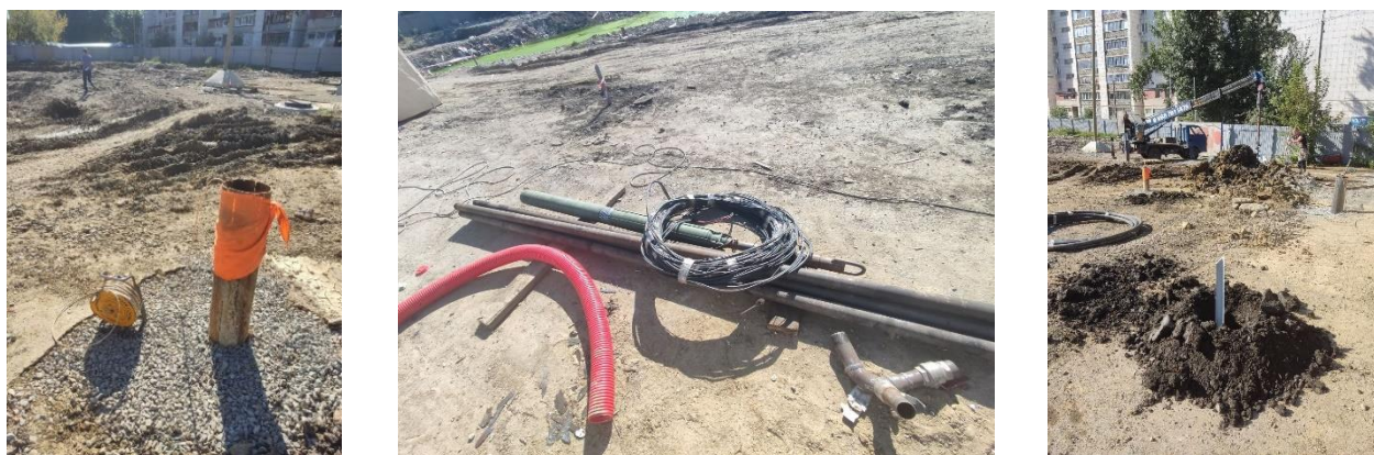
Рисунок 1 - Строительно-монтажные работы по установке элементов ГТМ
