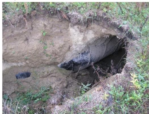
*Рис. 2. Обнажение трубы в карстовом провале МГ Ямбург - Зап. граница*
