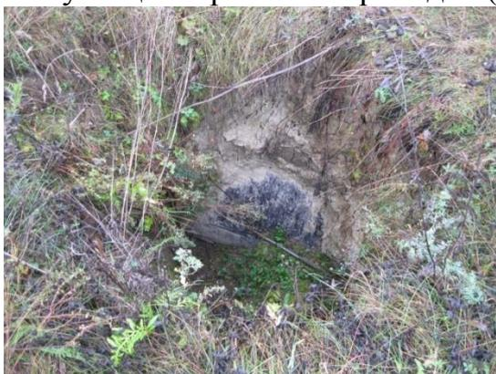
*Рис. 1. Обнажение трубы в карстовом провале МГ Ямбург-Елец1*
