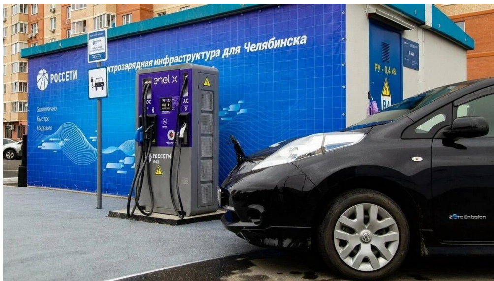
Рисунок 2 – Зарядная станция в г. Челябинск
