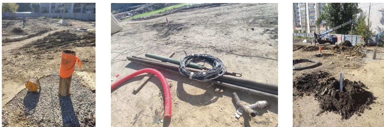
Рисунок 1 - Строительно-монтажные работы по установке элементов ГТМ
