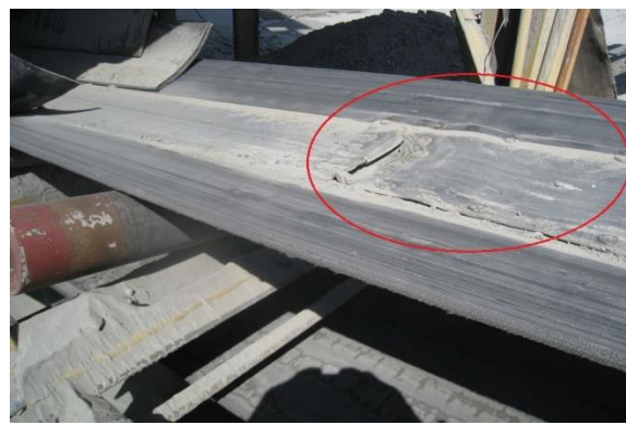
Ленточный конвейер (фабрика №2)
