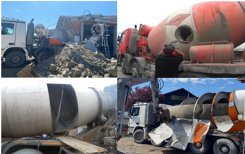
Рис. 2. Последствия отвердения бетона в смесительном барабане.
