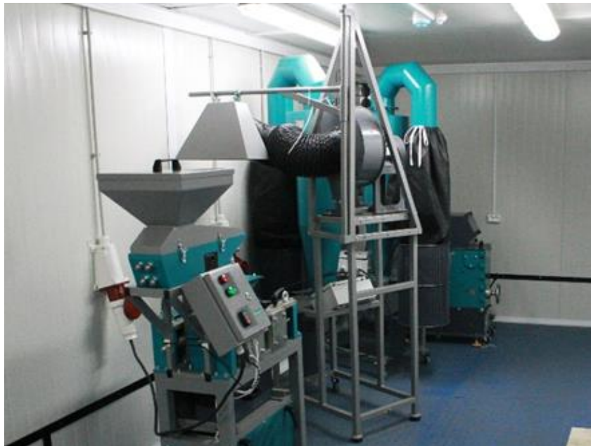
Рис. 1 Монтаж оборудования для пробоподготовки в мобильную лабораторию для ЗРК «Омчак»
