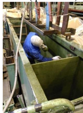
Фото 4. Защита (футеровка) ванн травления химстойким композитом
