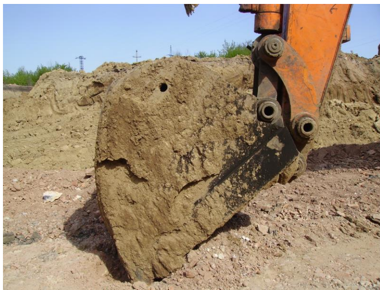
Рис. 2. Гидравлический экскаватор ЭО-5126 во время эксплуатации Fig. 2. Hydraulic excavator EO-5126 during operation
