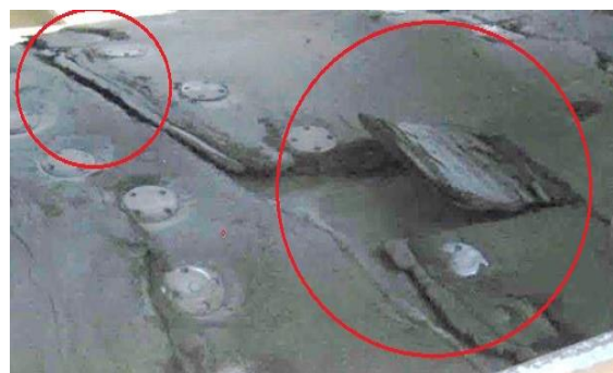
Ленточный конвейер (фабрика №4)
