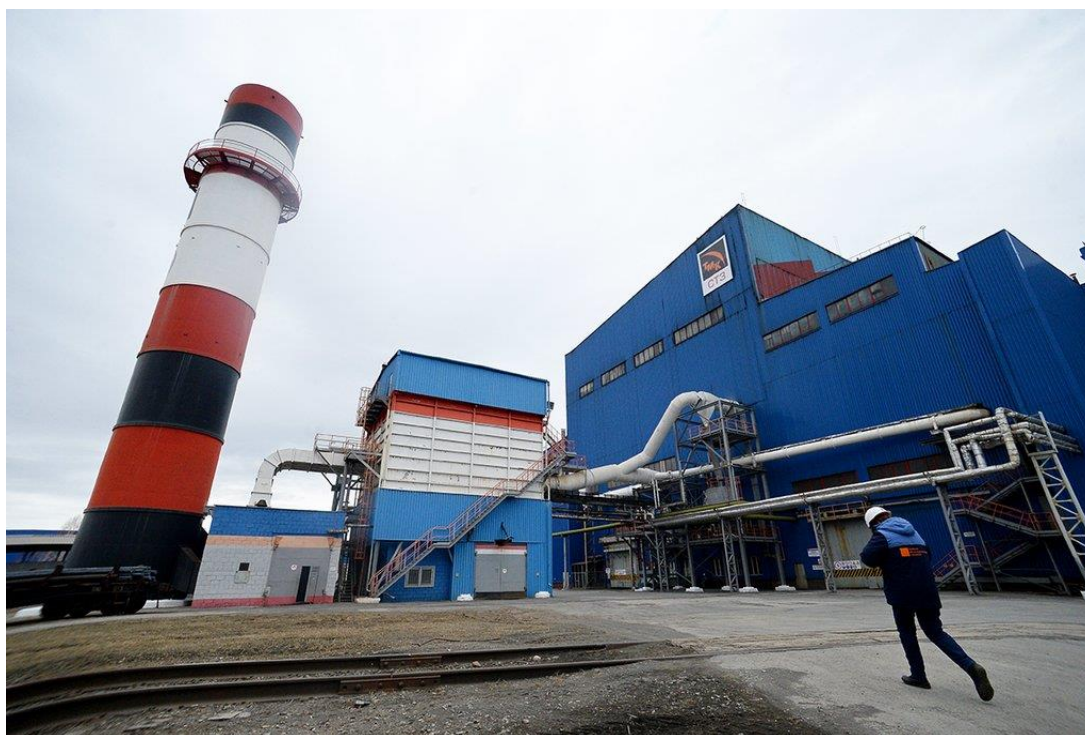
Рисунок 1. Газоочистные сооружения на ПАО «СТЗ»
