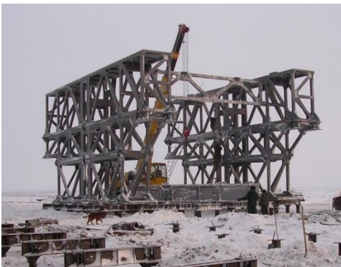
Рисунок 1 Основания рама на раму (англ. box-on-box)
