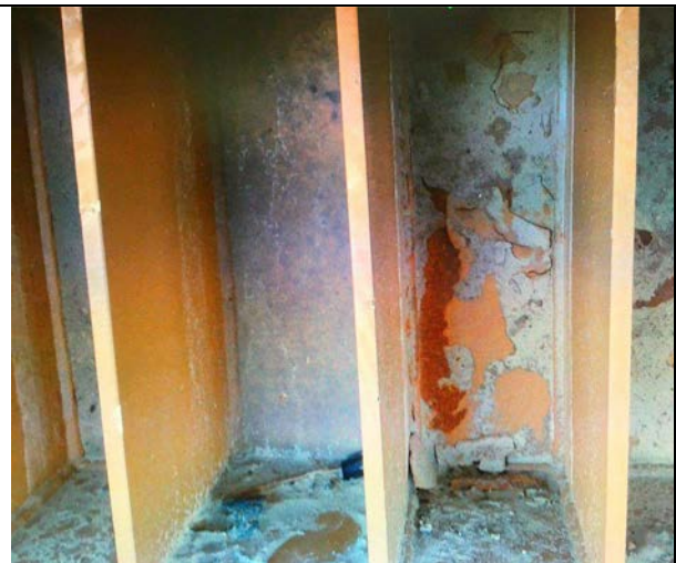
Рис. 4. Коррозия металлоконструкций
