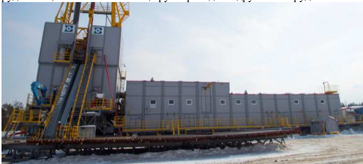
Рис. 3 Общий вид укрытия буровой установки
