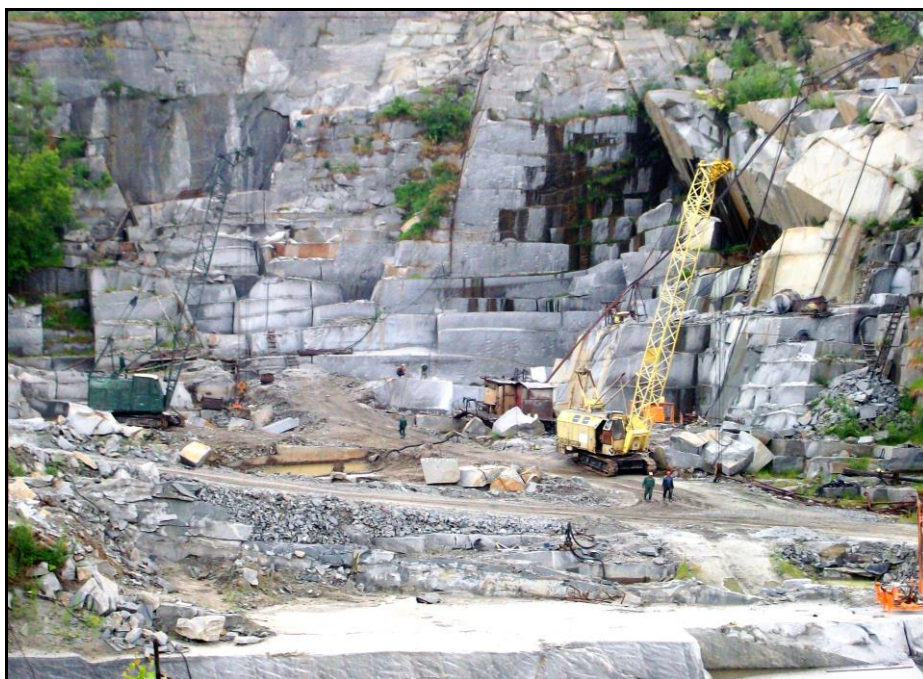
Рис. 22. Сибирский карьер по добыче облицовочных блоков гранитоидов
