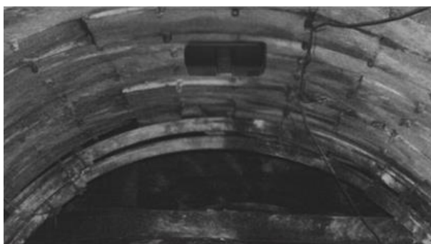
Рис. 4. Размещение прибора ИЗСТ-01 в горных выработках
